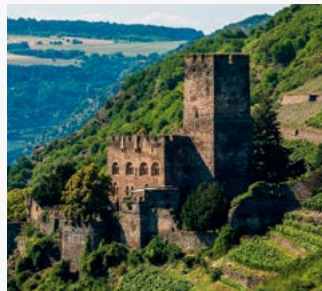
Gutenfels. Hotel. Kaub, Tyskland. Aquarea og Aquarea Smart Cloud.
